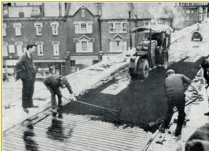
1969 Pose du revêtement sur la chaussée supérieure d'un carrefour de Hammerschmidt à Londres (Chauffage électrique des chaussées, par Robert Félix, 1971, Musée Ultimheat* )
